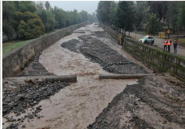
**Figura N°26:** Zona gaviones de contención y dissipador de energía aguas Quebrada de Ramón.
