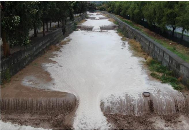
**Figura N°25:** Zona gaviones de contención y dissipador de energía aguas Quebrada de Ramón.
