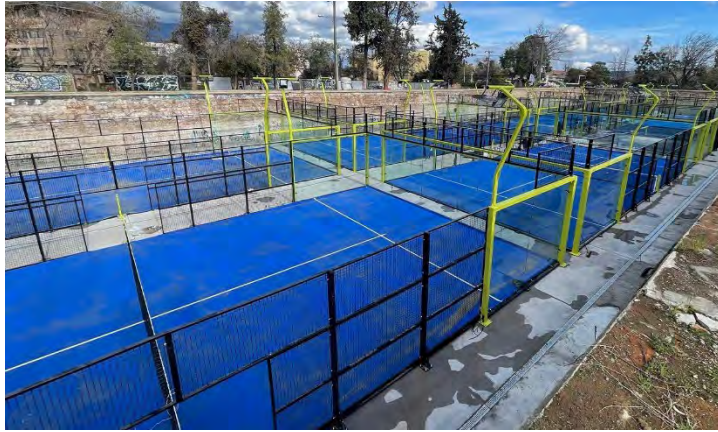
Habilitación canchas de tenis y cierre perimetral Estanque 2
