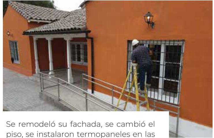
Se remodeló su fachada, se cambió el piso, se instalaron termopaneles en las salas de pintura y música, se repararon las ventanas y puertas, entre otros.
