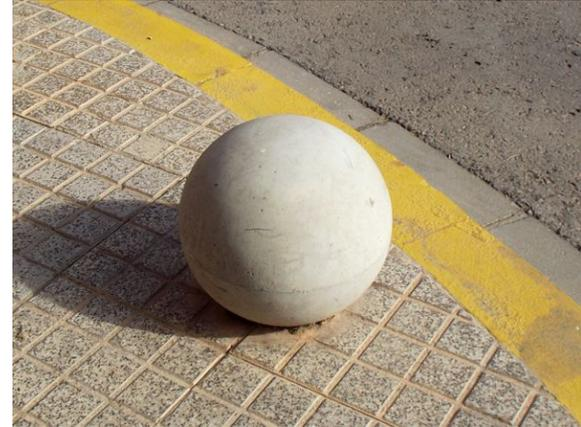
**Borlado:** Estos elementos están diseñados para evitar que los automóviles se estacionen sobre las baldosas. Están anclados con dos fierros de 1 cm de espesor y tienen un peso de 93 kg.
